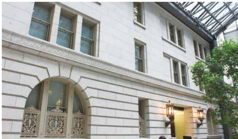
明治安田生命ビルアトリウム
